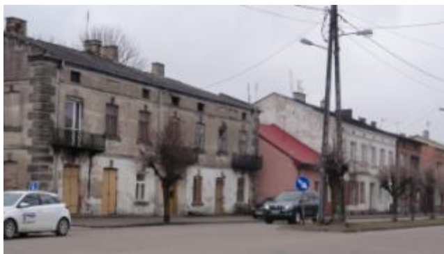
Zabudowa mieszkaniowa przy ul. Targowej
