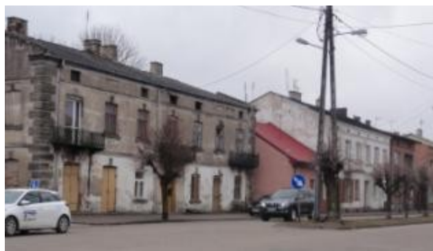
Zabudowa mieszkaniowa przy ul. Targowej
